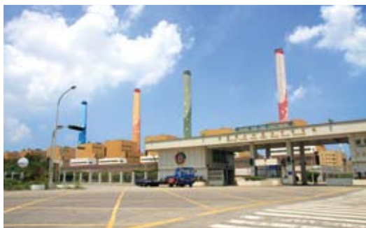
臺中火力發電廠
