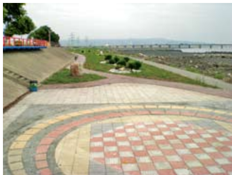
河濱公園（施工後）
