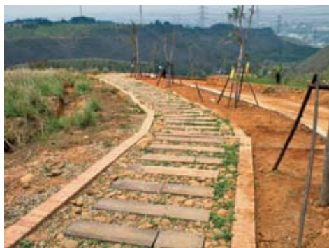
竹坑南寮登山步道（A段上部施工後）
