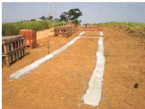
竹坑南寮登山步道（A段上部施工中）
