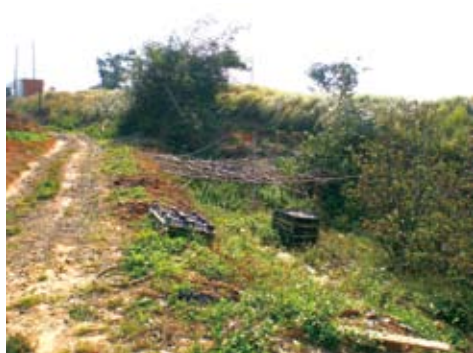
竹坑南寮登山步道（B段施工前）
