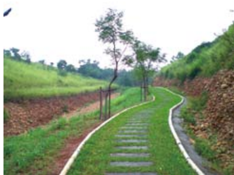
竹坑南寮登山步道（B段施工後）
